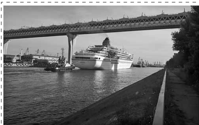
Рис. 5. Морской канал порта Санкт-Петербург, Путиловская набережная. Эстакада автомобильной магистрали Западного скоростного диаметра над Морским каналом
